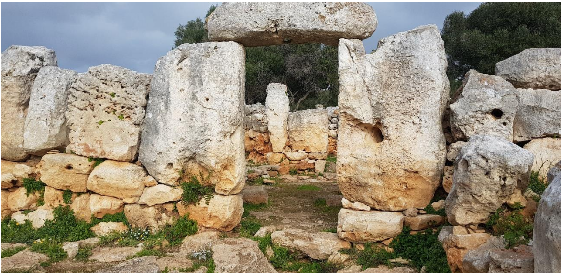
Pilars, columnes i dintell molt erosionats.
